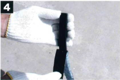
④ ネオスパンシールDSWの離型フィルムを剥がしてください。 (注)この面には接着剤は塗布しません。
