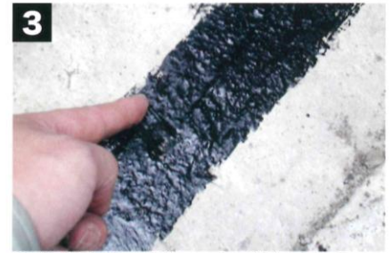
③ 接着剤は塗布後指でふれて粘着しない程度(塗布後10分以上)まで乾燥させた後、次の作業を行ってください。
