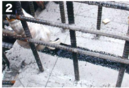
② 接着剤PB-50を30mm巾以上ハケで塗布してください。 (注) 接着剤PB-50は、蓋を開けたままにすると粘度が上昇しハケ塗りが困難になりますので、こまめに蓋を閉めてください。
