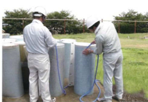
2.給水施工状況
