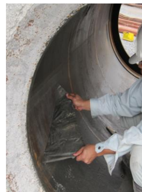
ヒューム管剥がし施工例
