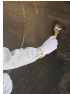
ヒューム管剥がし施工例
