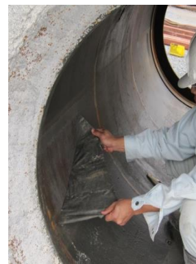
ヒューム管剥がし施工例
