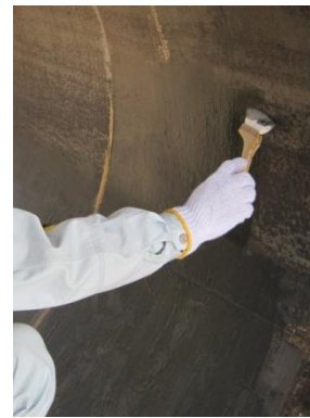
ヒューム管剥がし施工例
